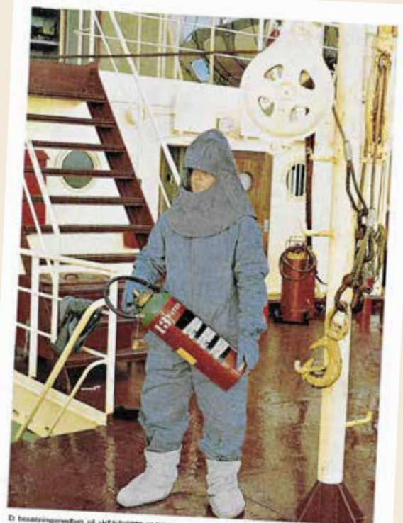
Et brandsikringsredskab på »HENRIETTE MÆRSK« har som led i en brandprøve fået sig en skål S.O.S.-dragt. Helt hvid, stærk og holdbar er fremstillet af asbest (Det. Anstalt).
